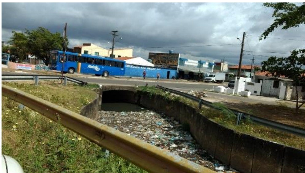
Figura 12: Ponto P6 de amostragem localizado no bairro José Conrado de Araújo
