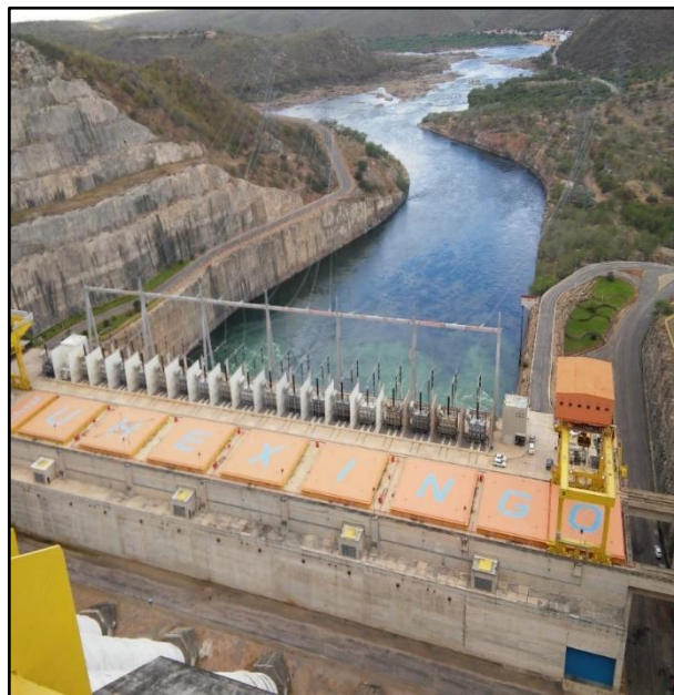
Figura 2 - Vista superior da Usina Hidrelétrica de Xingó, localizada entre os municípios de Piranhas/AL e Canindé do São Francisco/SE. Fonte: Acervo pessoal.
