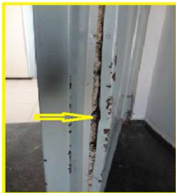
Figura 80 – Precariedade de uma porta corta-fogo encontrada em condomínio em Aracaju. Fonte: O Autor
