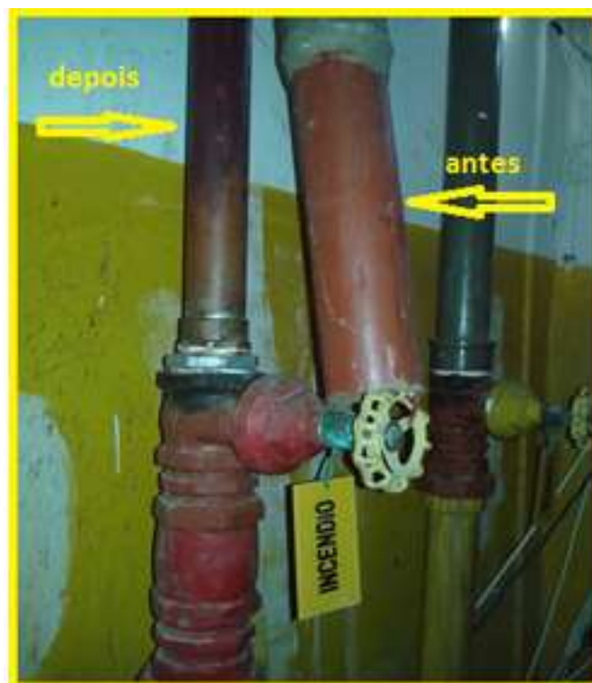
Figura 61 – Manutenção inadequada de um sistema hidráulico de combate a incêndio
