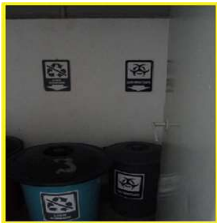
Figura 79 - Armazenamento de lixo infectante na entrada da escada de emergência em condomínio em Aracaju. Fonte: O Autor
