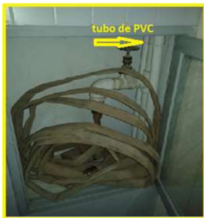
Figura 62 – Sistema hidráulico preventivo de combate a incêndio instalado em PVC, acoplado com mangueiras para incêndio ressecadas.
