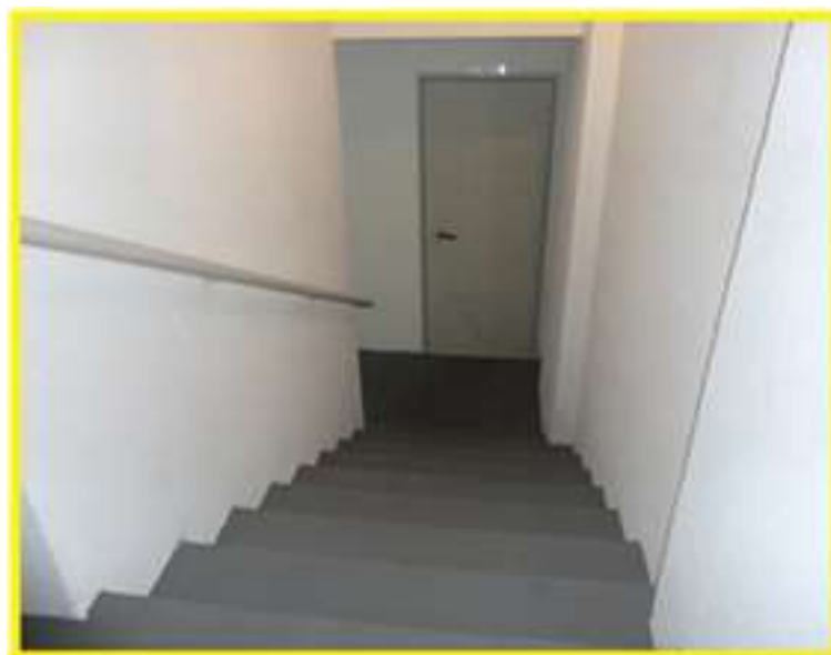
Figura 41 – Escada de emergência com corrimão apenas de um lado e intermitente Fonte: O Autor
