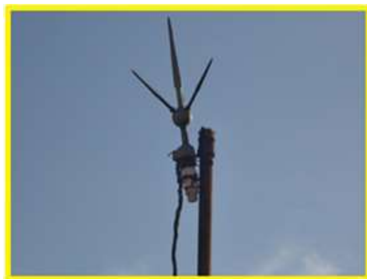
Figura 16 – Sistema de SPDA com o captor de raios quebrado da haste
