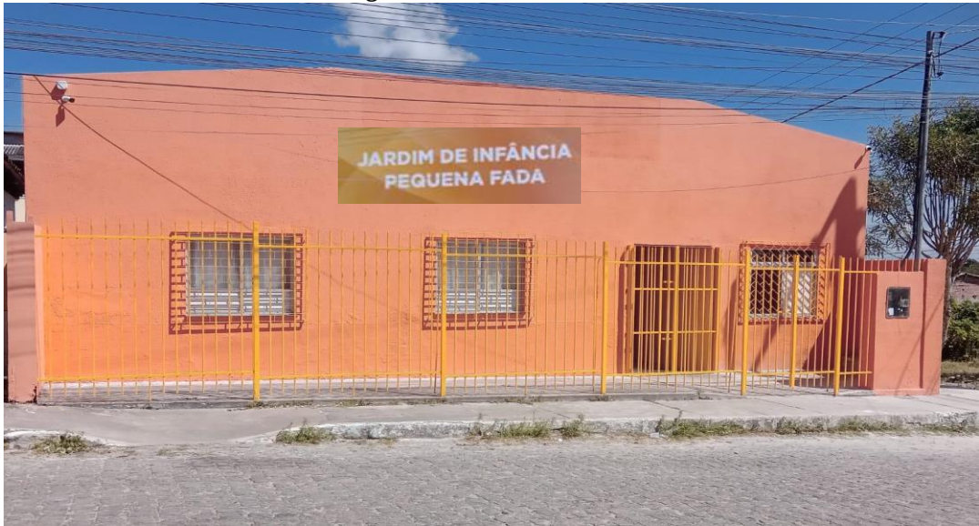
Figura 23: Fachada frontal – E1
