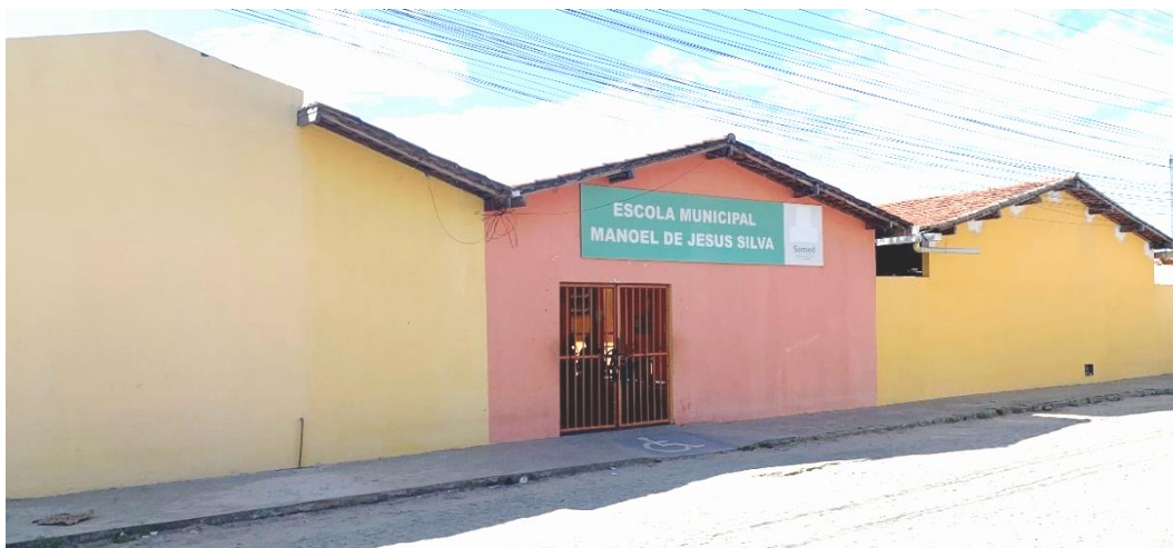
Figura 25: Fachada frontal E3
