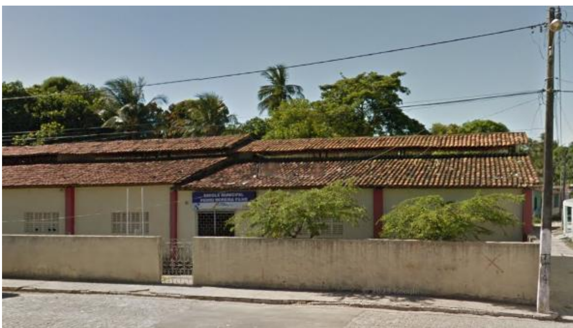
Figura 24: Fachada frontal E2
