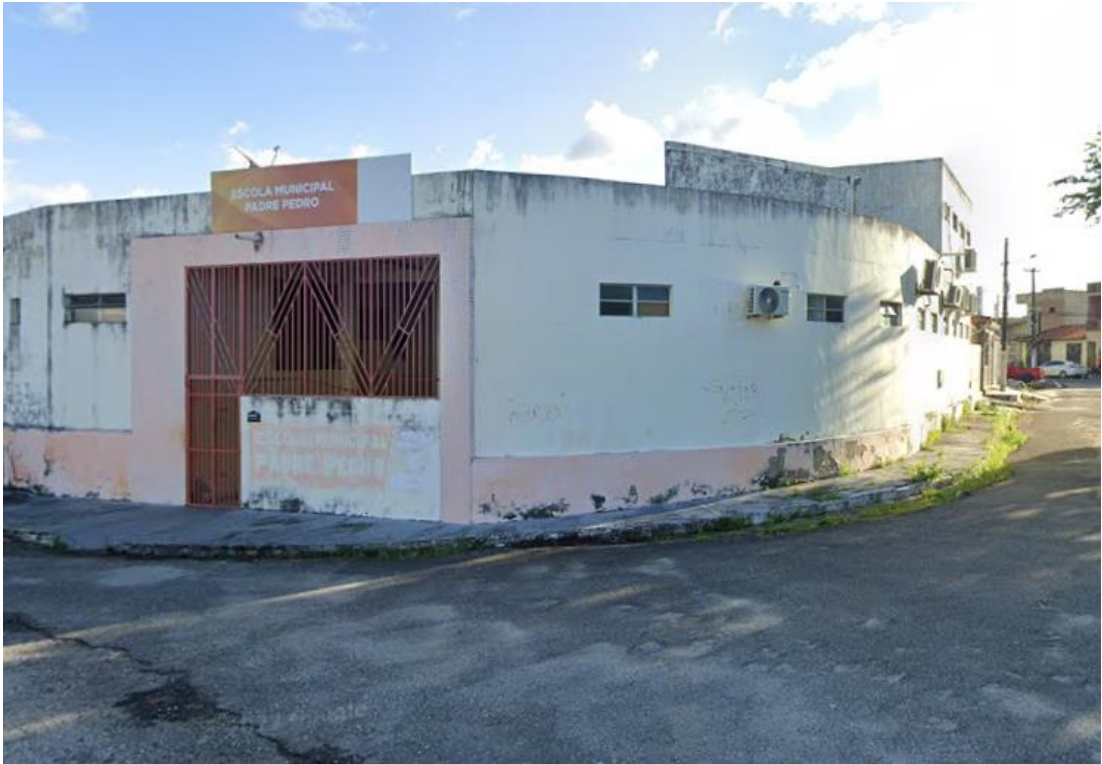
Figura 26: Fachada frontal E4
