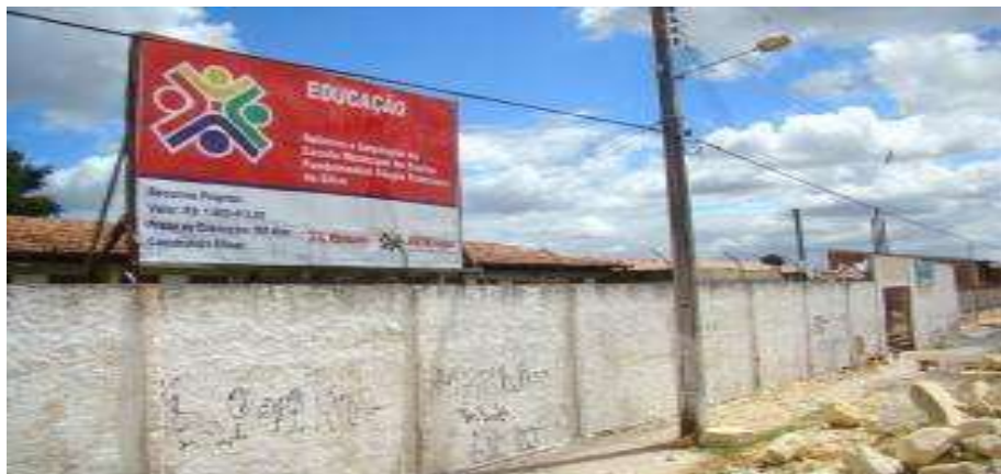
Figura 5 - Foto da reforma da EMEF Sérgio Francisco da Silva em 2010
