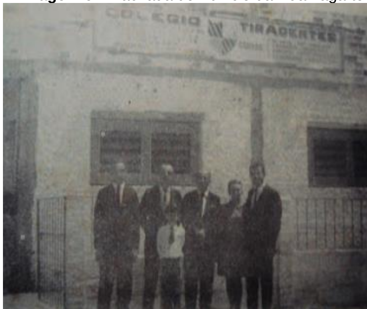
Imagem 64: Fachada do Edifício da Rua Lagarto
