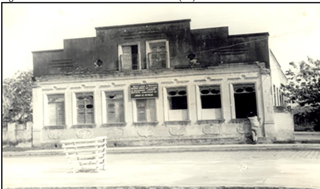
Figura 6 – Fachada do casarão antes da reforma (s/d)
