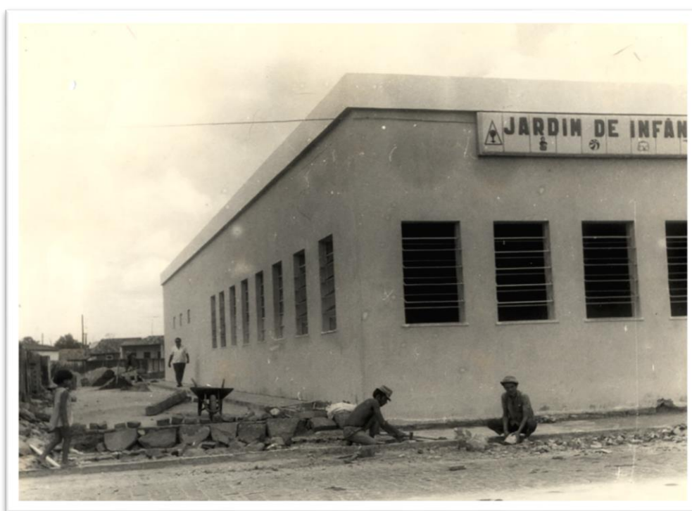
Figura 15 – Obras do Jardim de Infância Joana Ramos (1969)
