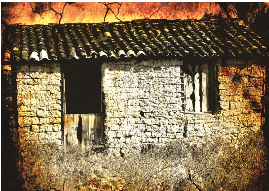
Figura 4 – Fachada da Escola Isolada da Fazenda Major – 1970
