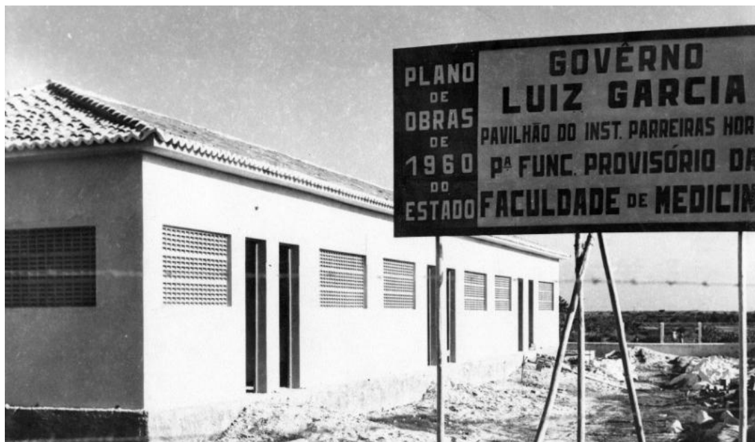
Figura 13 – Construção do prédio para sediar provisoriamente a Faculdade de Medicina de Sergipe, no pavilhão do Instituto Parreiras Horta, em 1960.
