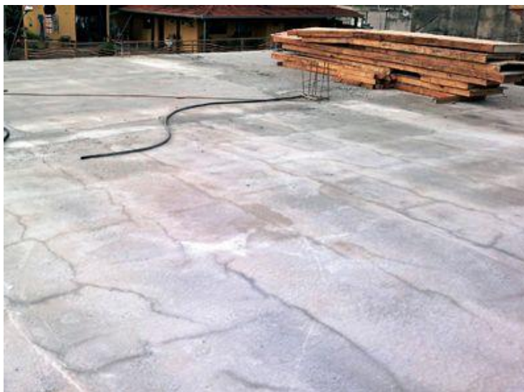
Figura 3: Fissuras por retração na fase plástica do concreto devido à perda rápida de água e ausência de cura. Fonte - http://construcaomercado.pini.com.br (Acessado 10 mai. 2017)
