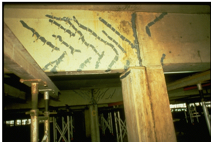
Figura 5: Tratamento de aberturas no concreto com métodos convencionais. Fonte: http://www.reitec.com.br (Acessado 10 mai. 2017)
