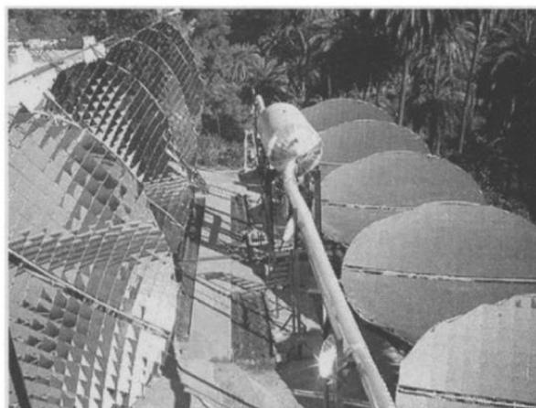
Figura 16: Instalação do módulo com 10 concentradores no Hospital Global, em Mount Abu. São observados concentradores em alturas diferentes, os receptores e o tanque principal, onde o vapor é armazenado (PAHISSA, 2014).
