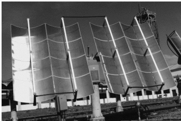
Figura 17 – Coletor cilíndrico parabólico instalado na Plataforma Solar de Almería na Espanha. Fonte: ALFANO et al. (2000)
